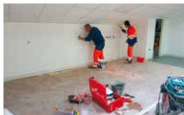
Travaux en régie Médiathèque
