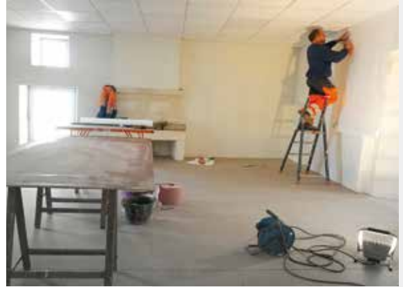
Aménagement de la Médiathèque par l'équipe Bâtiments des services techniques municipaux
