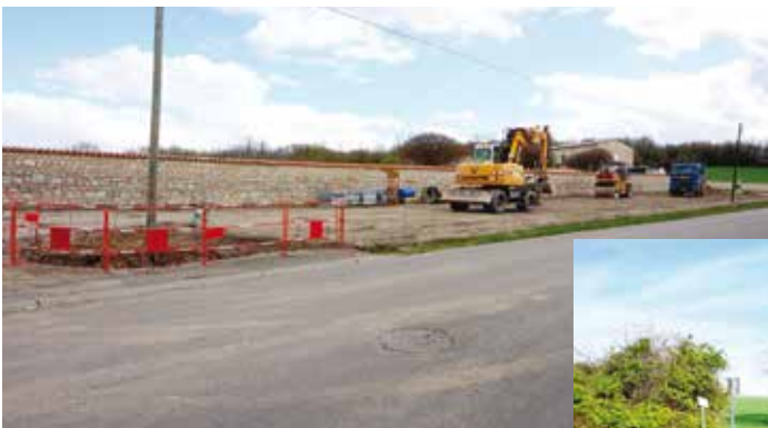
Aménagement du parking au cimetière Travaux en cours
