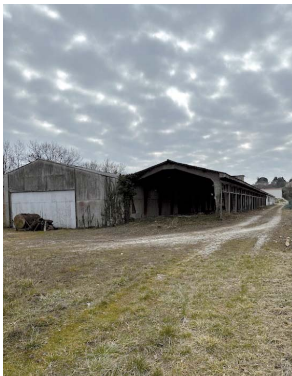
Friche industrielle en cours de défrichage
